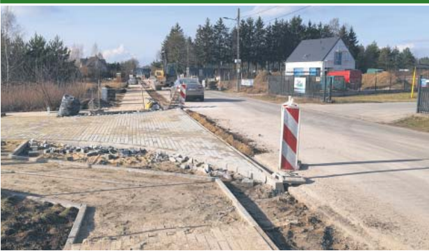
Chodnik ul. Kościelna w Skrzeszewie
