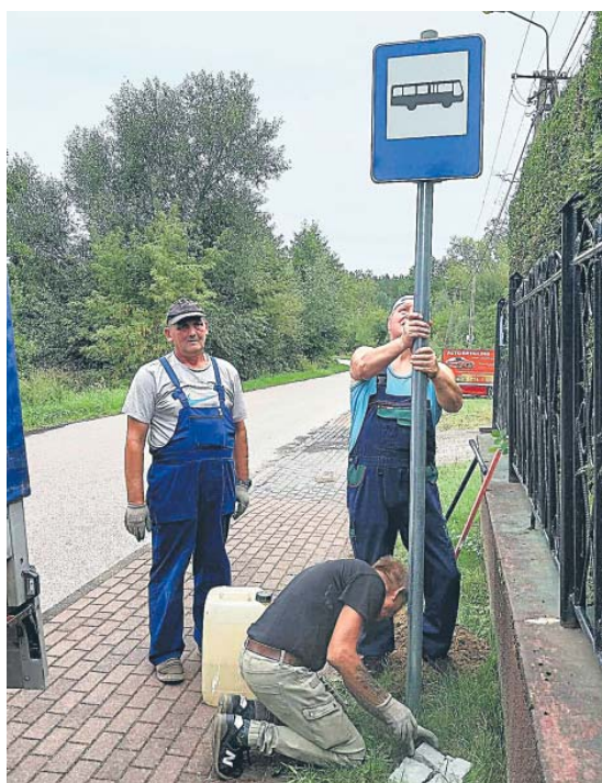
Trwają ostatnie prace przy montowaniu znaków na nowych przystankach
