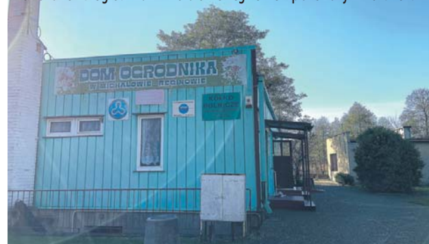
Remont Domu Ogrodnika w Michałowie Reginowie – planowany w 2023 roku
