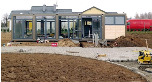
Olszewnica Nowa – budynek w trakcie budowy
