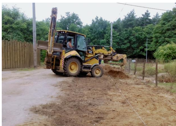
Budowa drogi gminnej – ul. Leśnej w Wieliszewie
