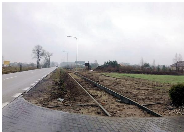
Budowa chodnika w Krubinie
