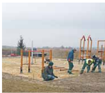
Budowany plac zabaw w Wieliszewie
